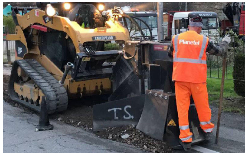
I lavori di posa della fibra ottica, recentemente terminati, da parte di Planetel nei nostri territori
